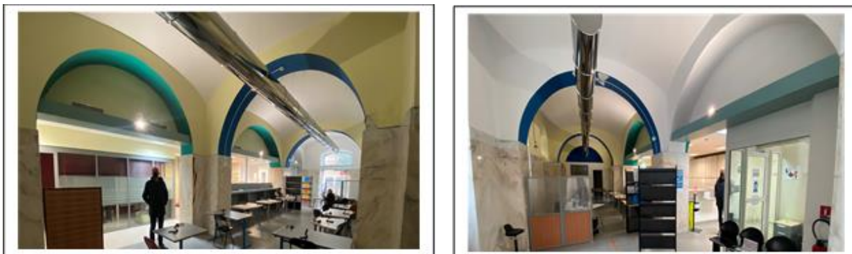
Ci-dessus, les espaces en RDC sur la partie avant du local ancien CRIJ
