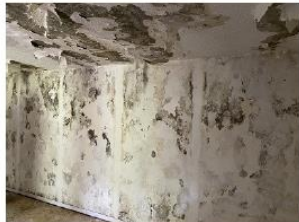
Nombreuses traces d'humidité murs et plafond
