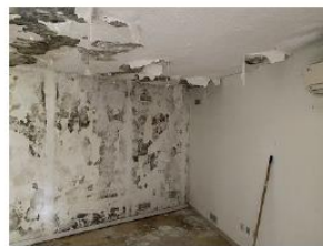
Nombreuses traces d'humidité murs et plafond
